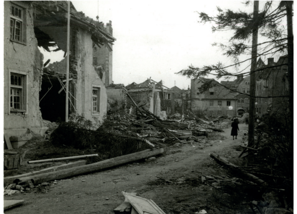
Zerstörte Kreissparkasse am Bahnhofsfußweg
