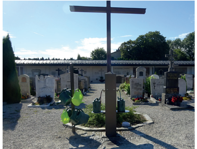
Eine der neuen Wasserentnahmestellen am Stadtfriedhof
