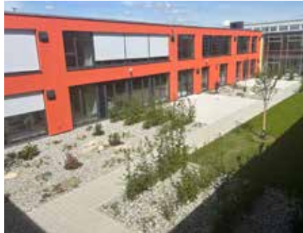
Der Erweiterungsbau der Mittelschule mit Lichthof
