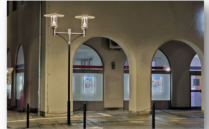
Reduzierung von Energieverbrauch, Betriebskosten und Beeinträchtigung der natürlichen Umgebung durch moderne Straßenbeleuchtung
