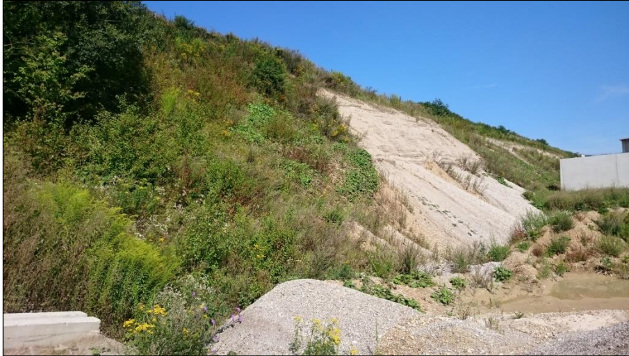
Blick auf die ostexponierte Böschung neben der Recyclinghalle
